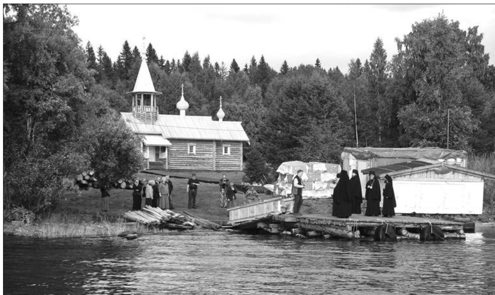
Остров Большой Клименец, Свято-Троицкий монастырь, новопостроенная Никольская церковь
