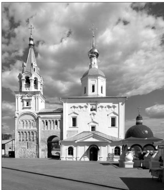
Собор Рождества Богоматери в Боголюбове и переходы с лестничными башнями к дворцу князя Андрея Боголюбского. 1158–1165
