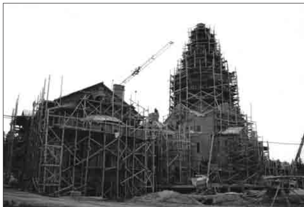
На строительстве скита. 2007 г.
