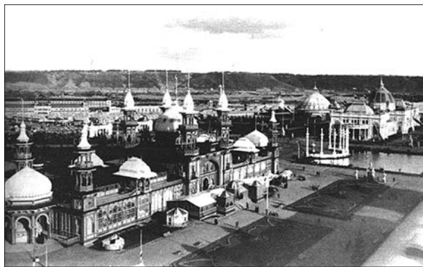
Нижегородская ярмарка (снесенные здания)*
